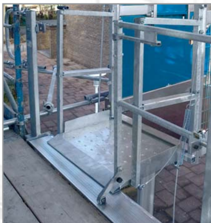
Lastsituation med öppnad lastramp – ramplängd 0,6 m
